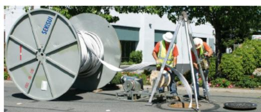
Com um sistema de juntas, torna-se um revestimento estanque. Há dois
